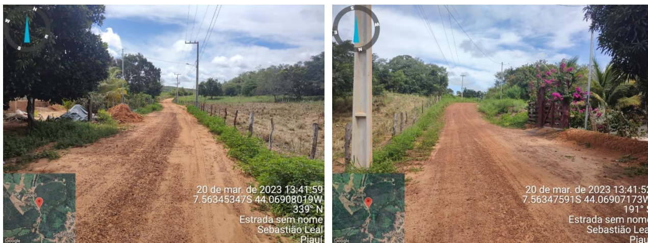
Figura 4: rua a ser pavimentada
