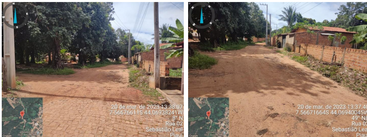
Figura 3: rua a ser pavimentada
